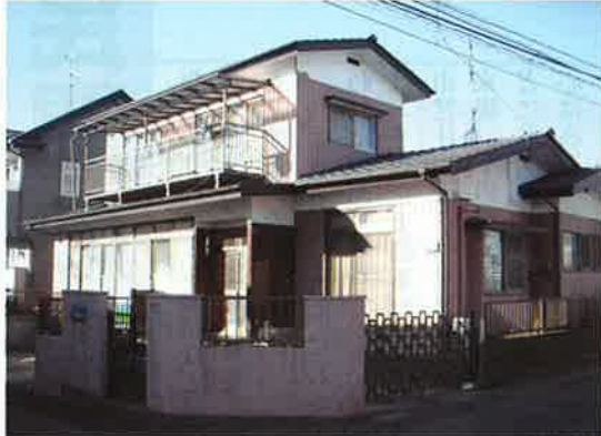
北洲が行う中古注文住宅システム「北洲プラスアール」の施工例。上が施工後、下が施工前
